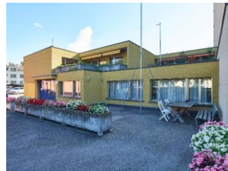
ReUse on site, Pflanztröge als Einfassung
