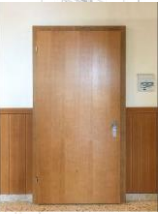
Brandschutz- türen (aus Schulhaus Lavater)
